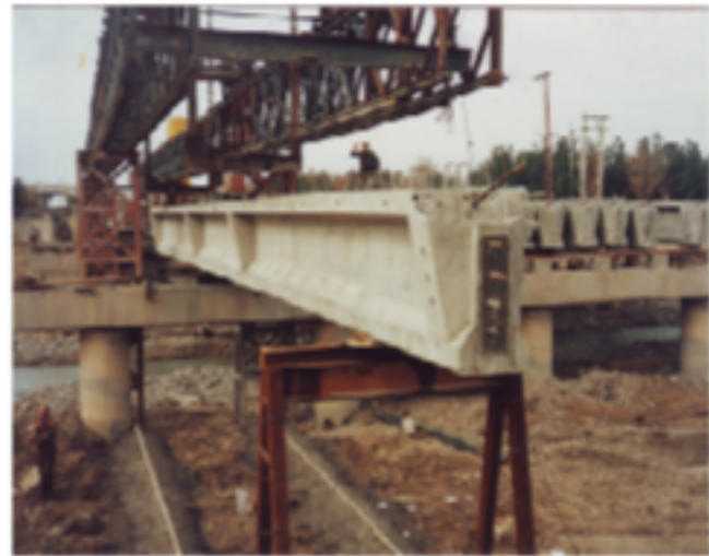
( تیرهای پل پیش ساخته )
