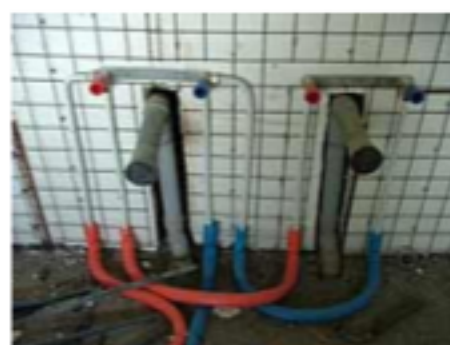
کار گذاری لوله های تاسیساتی
